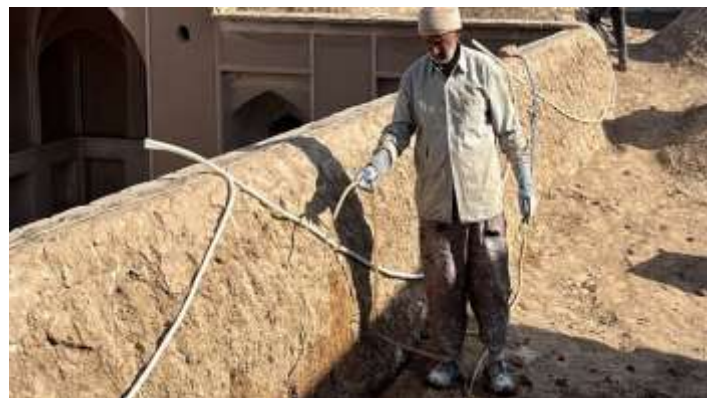
تصاویر شماره ۷: مرمت خانه تاریخی قارنی
