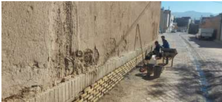
تصویر شماره ۹: مرمت دیوار غربی بنا از سمت معبر
