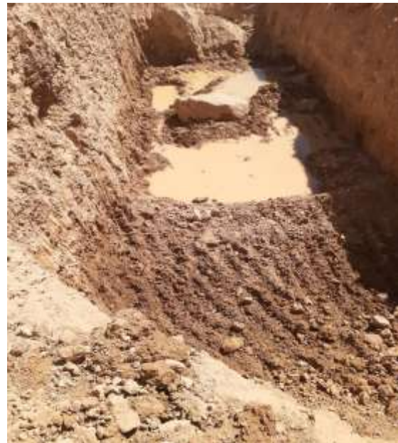
تصاویر شماره ۲۳: عملیات سرشکاف کردن قنات
