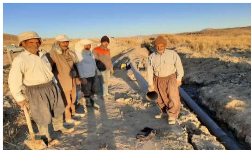
تصویر شماره ۱۶: عملیات لوله گذاری قنات شورود وسط
