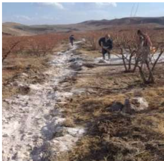
تصویر شماره ۱: شفته ریزی مسیرهای آب با آهک
