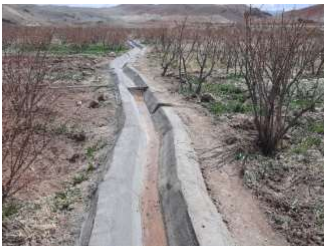
تصویر شماره ۳: اجرای کانال بتنی پس از شفته ریزی و قالب بندی
