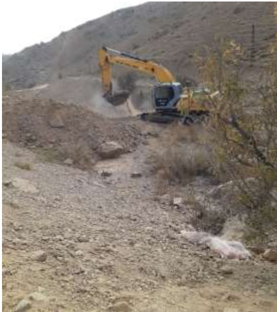
تصاویر شماره ۲۳: عملیات سرشکاف کردن قنات
