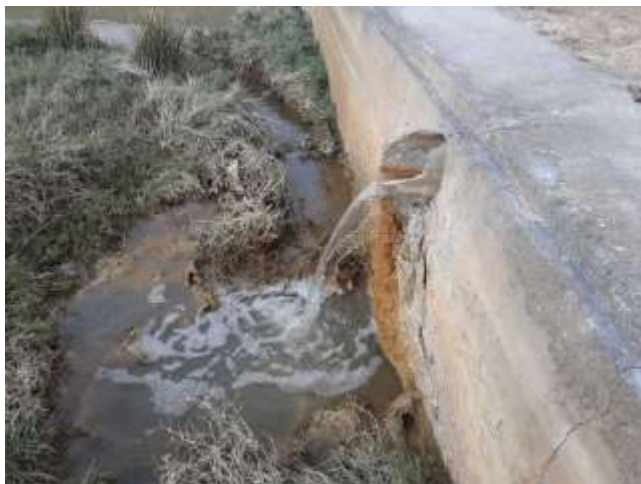
تصویر شماره ۱۰: میزان آبدهی قنات بعد از باربرداری و اجرای عملیات سرشکاف
