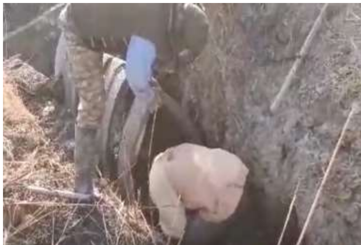
تصویر شماره ۱۷: عملیات کول گذاری قنات شورود وسط
