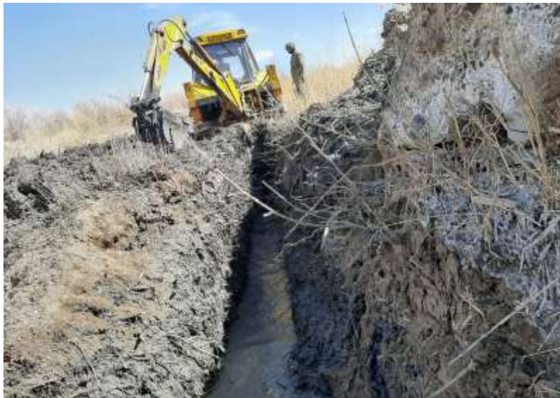
تصویر شماره ۸: باربرداری محل آبخیز قنات شورود پایین
