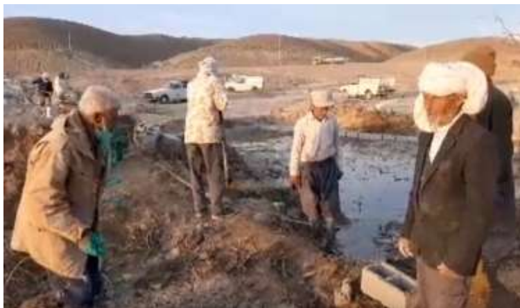
تصویر شماره ۱۸: عملیات مرمت حوضچه ها و استخر بالا
